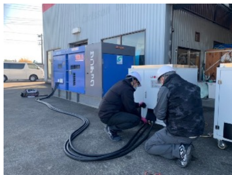
(仮設発電機を使用した試運転)
